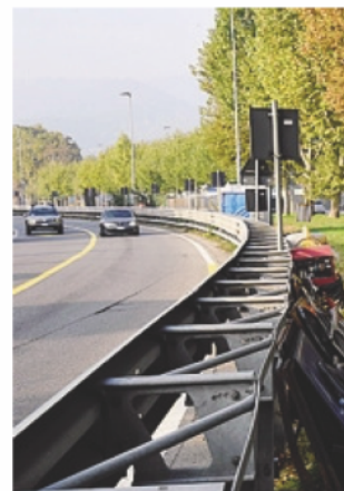
Il cantiere in via delle Valli
