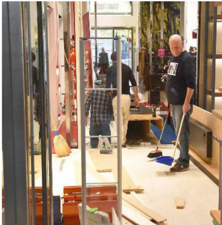
I DANNI I lavori di ripristino all'interno della boutique saccheggiata. I malviventi hanno distrutto una vetrina con un'auto ariete (De Pascale)
