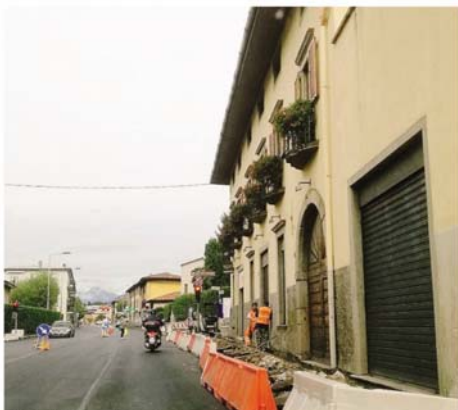
Il cantiere al Pontesecco, al confine fra Bergamo e Ponteranica
