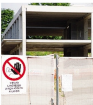
Il cantiere per la Montessori
