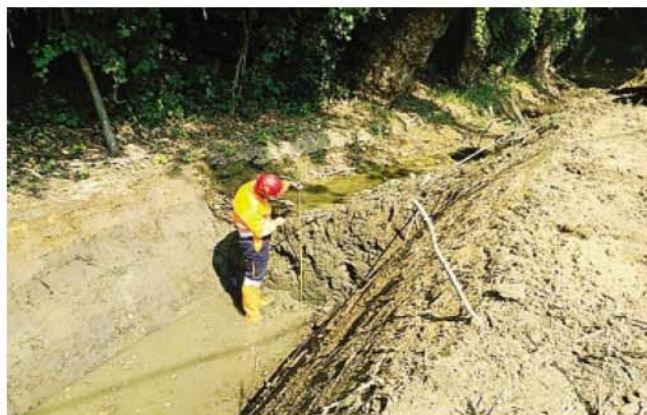
La roggia Curna, durante i lavori eseguiti di recente
