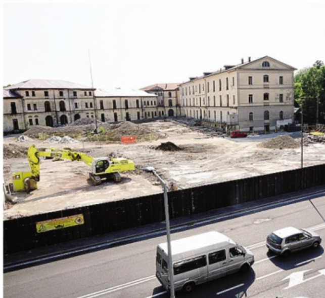
Il cantiere della Montelungo, uno degli interventi discussi
