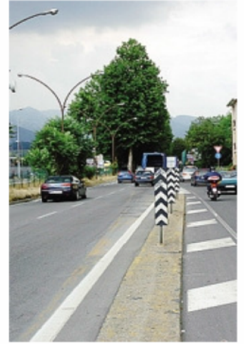
Via delle Valli: lavori in vista
