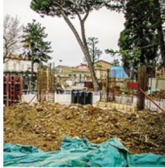
Il cantiere dell'infopoint COLLEONI
