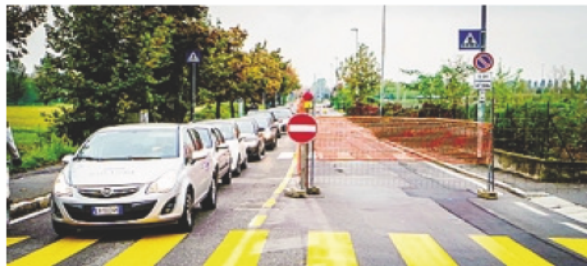
Auto in coda per il cantiere in via King
