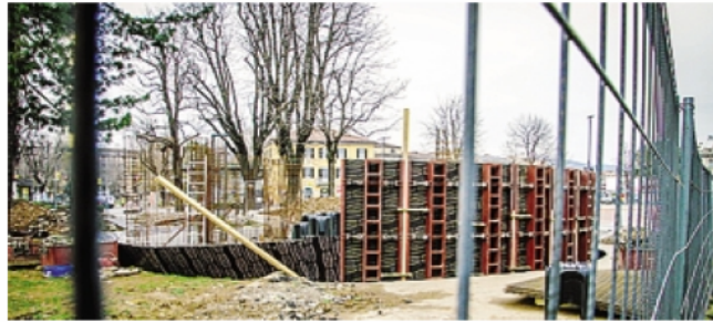
Il cantiere dell'Ufo, fermo da qualche mese
