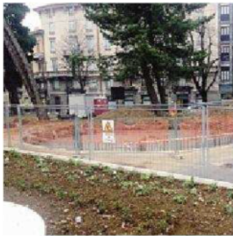
Il cantiere per l'Ufo
