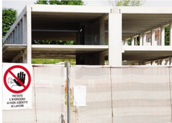
Il cantiere della scuola Montessori a Longuelo FOTO FRAU
