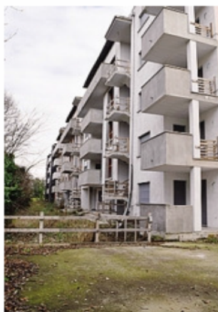
Il cantiere a Borgo Palazzo
