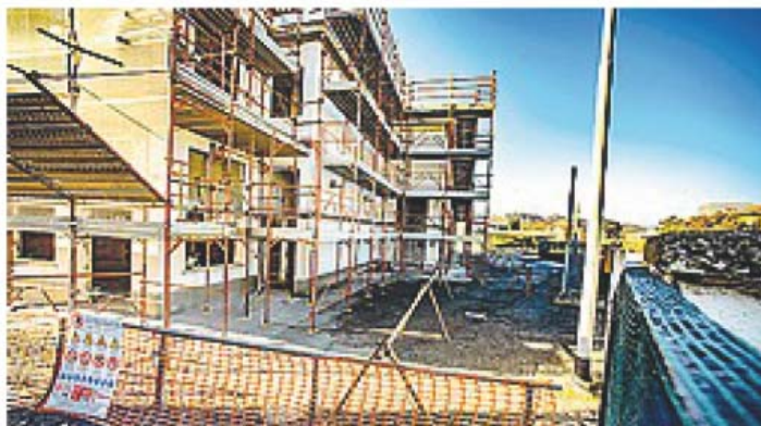
Tutto bloccato Le impalcature nell'area dell'ex Fiat di via San Fermo
