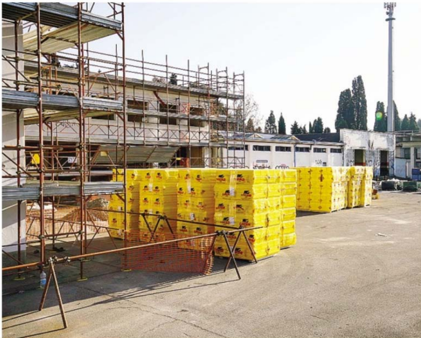
L'edificio di via San Fermo, sul quale già insisteva un cantiere, sequestrato dalla Procura FOTO COLLEONI
