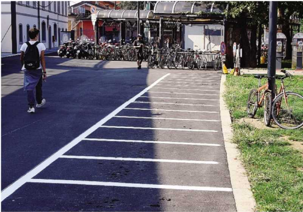
I nuovi stalli per le moto realizzati ieri alla stazione FOTO BEDOLIS
