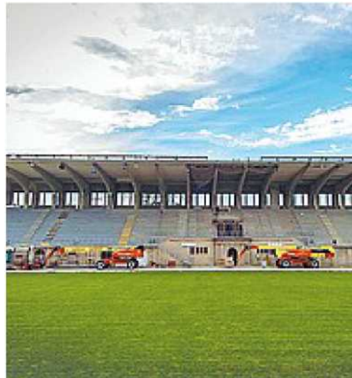
Lavori in corso Restyling sull'Azzurri d'Italia
