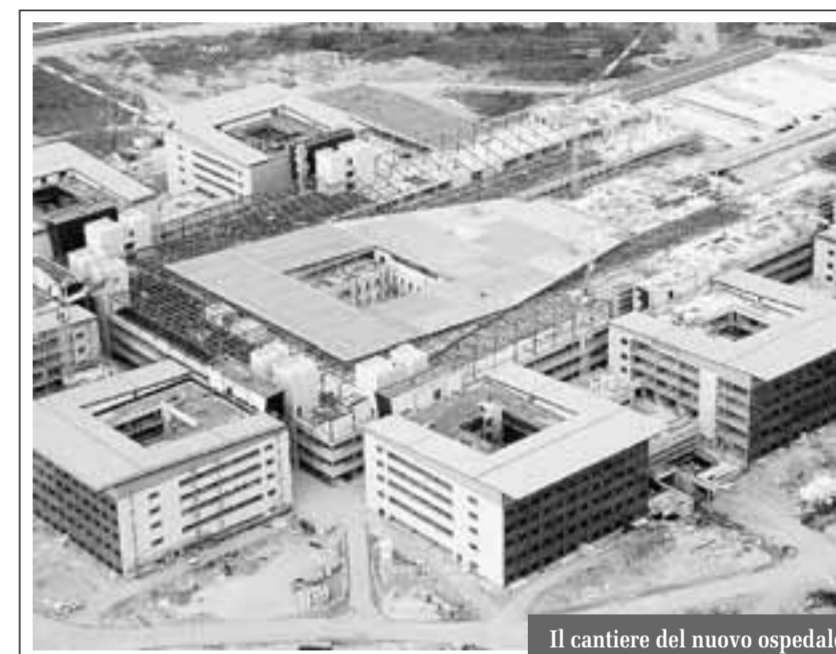
Il cantiere del nuovo ospedale
