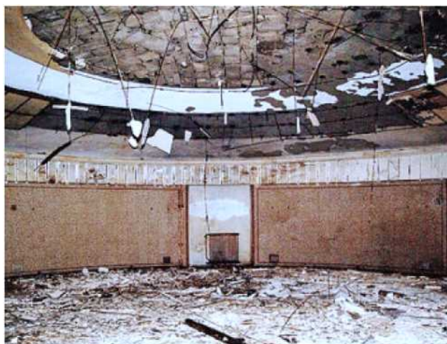
Il complesso sotterraneo dell'ex albergo diurno
