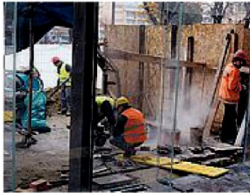
CANTIERE Operai al lavoro ieri
