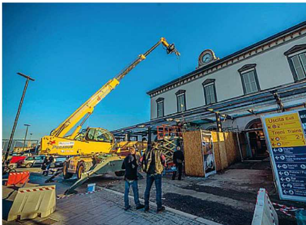
Cantiere I lavori all'atrio della stazione ferroviaria di piazzale Marconi
