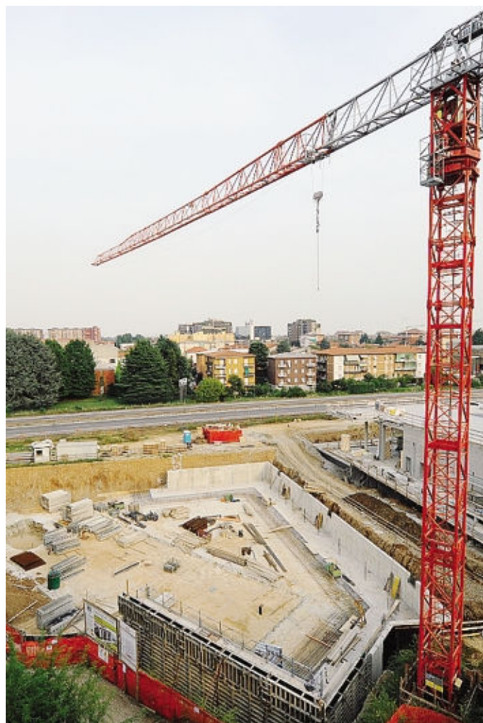
Lo scavo per l'albergo di via Autostrada
