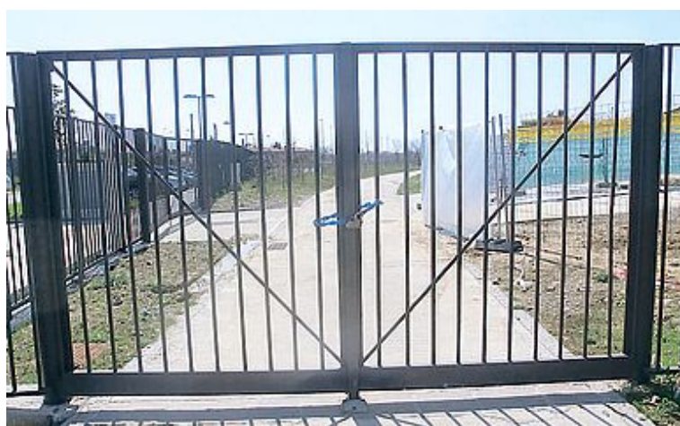
ACCESSO BLOCCATO Il cancello che interrompe il percorso dall'ingresso alla Torre 1, dove c'è l'area di sosta per le biciclette
