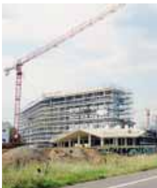
Il cantiere in via Autostrada
