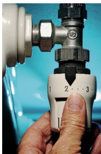
Nelle scuole avviati i primi interventi sulle valvole
