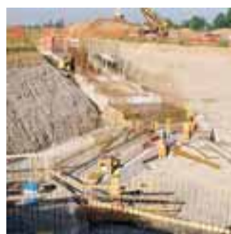
I cantieri di Brebemi
