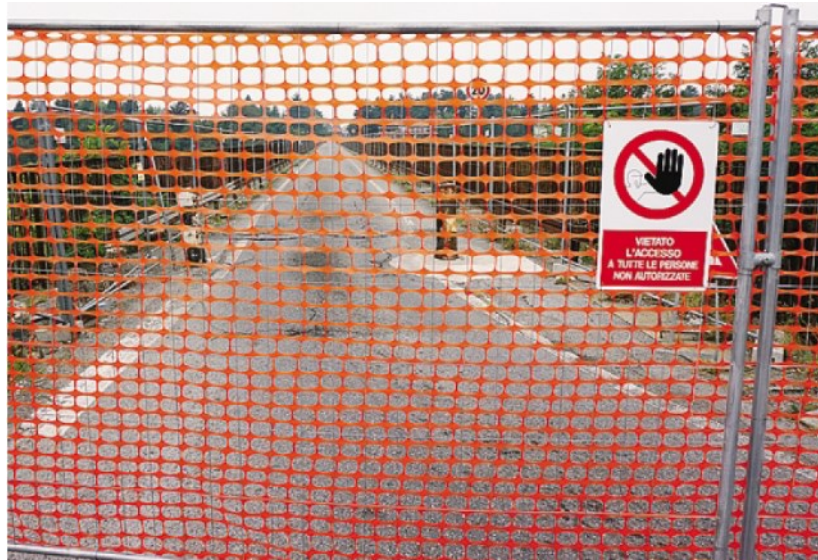
Il ponte San Michele transennato tra Calusco e Paderno
