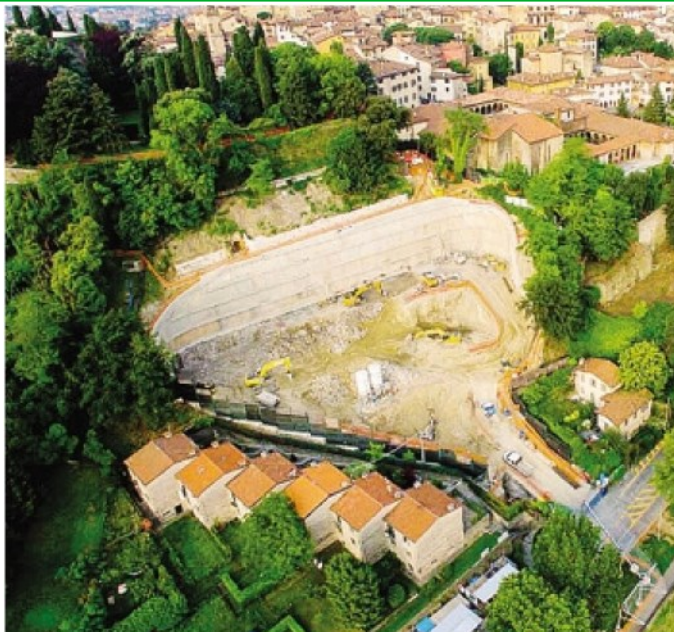
Il cantiere per il parcheggio fotografato dall'alto
