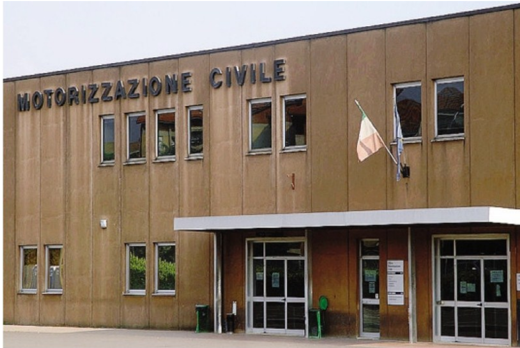
Rinforzi in vista per la Motorizzazione di Bergamo
