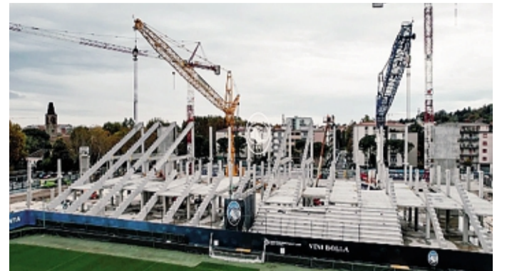
L'avanzamento dei lavori FOTO TRATTA DAI SOCIAL DELL'ATALANTA
