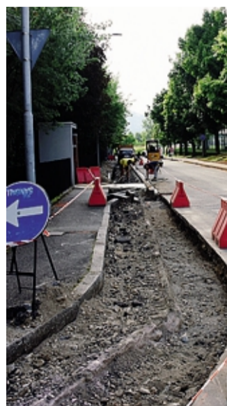
Il cantiere in via don Guanella
