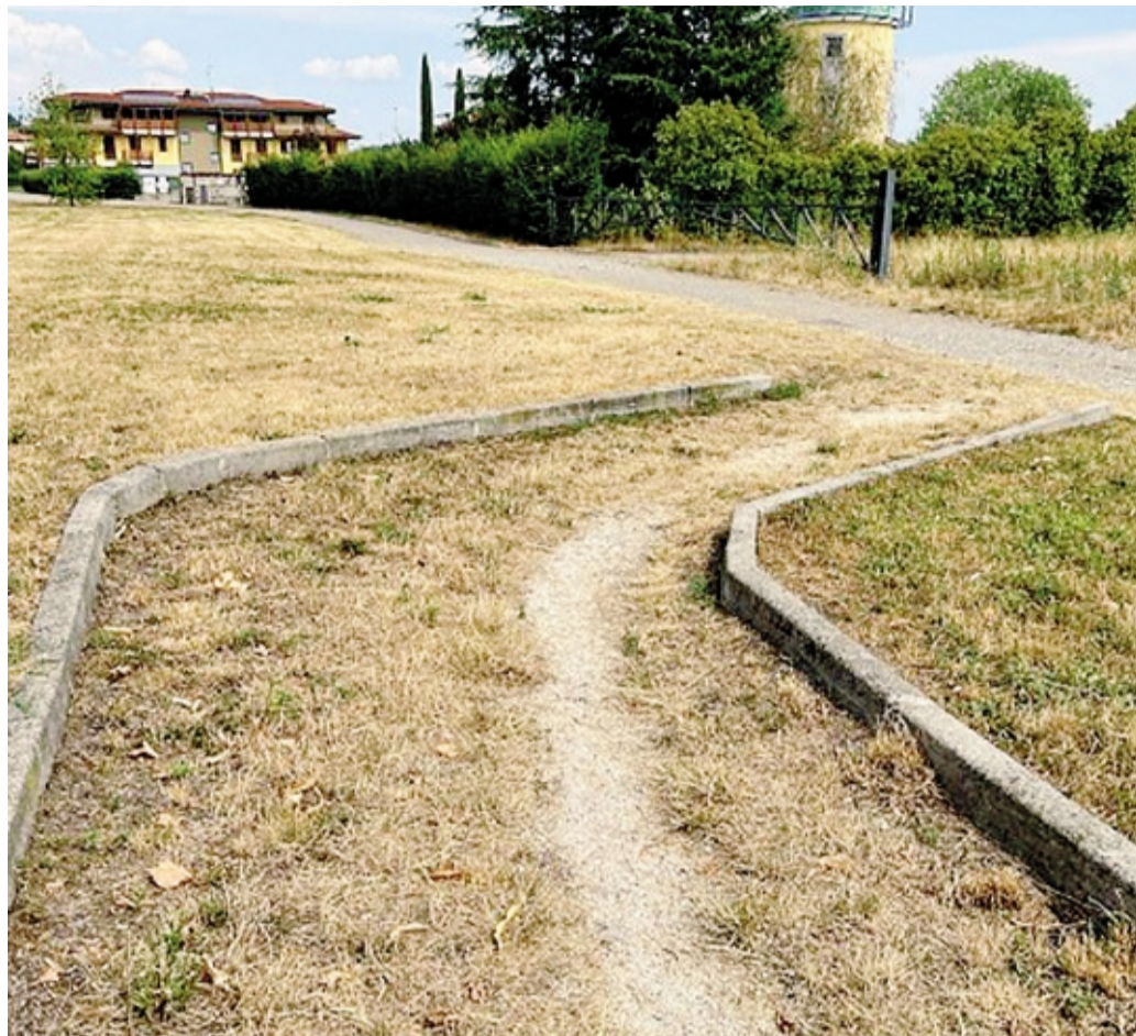
Previste diverse sistemazioni di tratti già esistenti, come questo al di sotto del sottopasso della Tangenziale Sud in corrispondenza di via Dolomiti, in Comune di Seriate: sarà rifatta la pavimentazione
