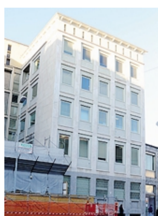
Palazzo Uffici (via Tiraboschi)
