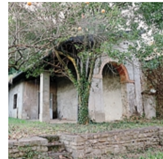
L'ex casa del custode alla Carrara
