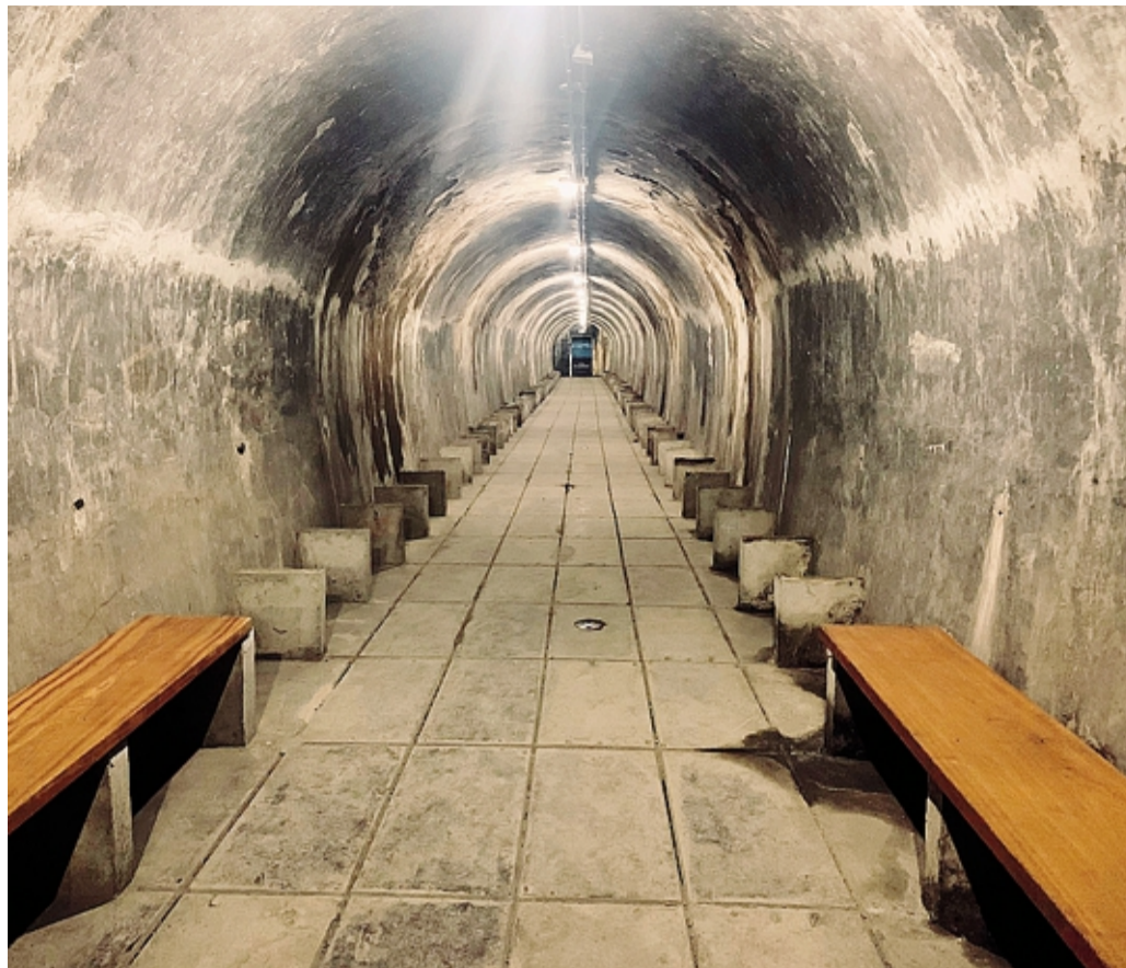
L'interno del rifugio ora ristrutturato nel quartiere Garbagni: poteva ospitare fino a 500 persone
