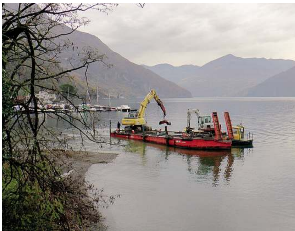
I lavori nel lago tra Pisogne e Marone, alla foce dei torrenti Bagnadore e Trobiolo
