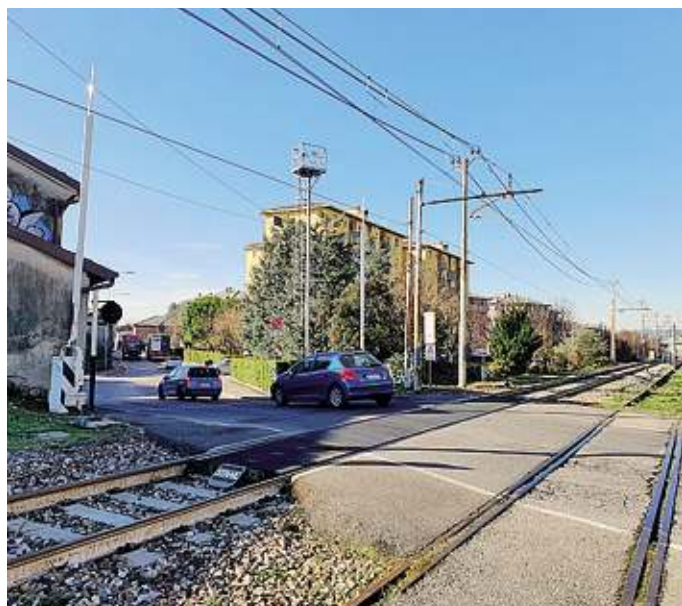
Il passaggio a livello di via Pizzo Recastello a Boccaleone
