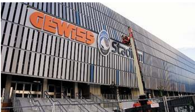
Con gli ultimi lavori ecco anche la scritta Gewiss Stadium BEDOLIS
