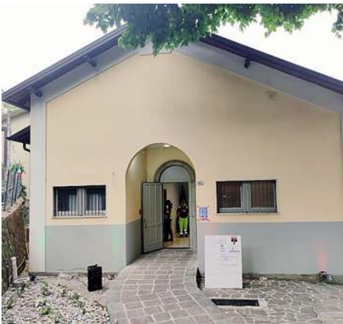
La nuova sede della Protezione civile Bergamo Ovest a Ponte
