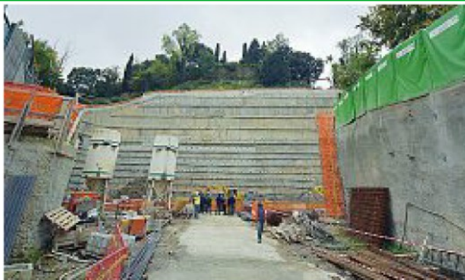
Il cantiere I lavori, in questa seconda fase, sono iniziati a settembre 2017
