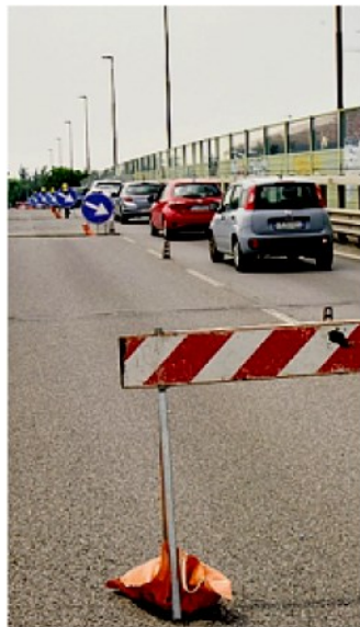
Lavori sul viadotto FOTO BEDOLIS
