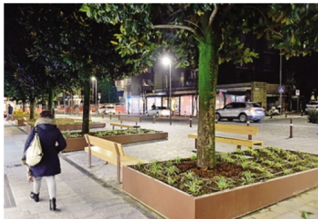
Lavori finiti nella piazzetta di Santa Lucia FOTO BEDOLIS
