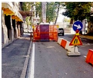
Il cantiere in via Bonomelli
